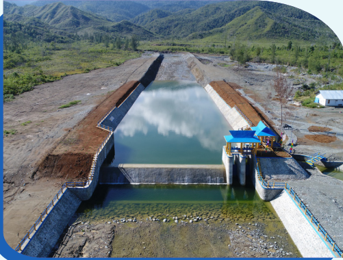
Bendungan Dakaino, Maluku Utara
