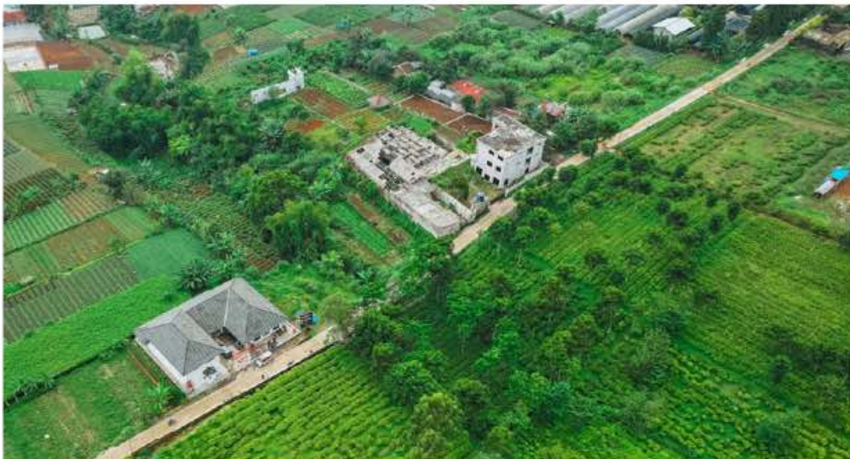
Jalan Perkerasan Beton, Kec. Pacet, Kabupaten Cianjur, Jawa Barat
