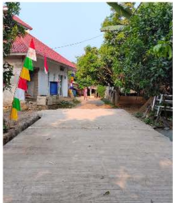
Jalan Perkerasan Beton, Kec. Jambu Kab. Semarang, Jawa Tengah
