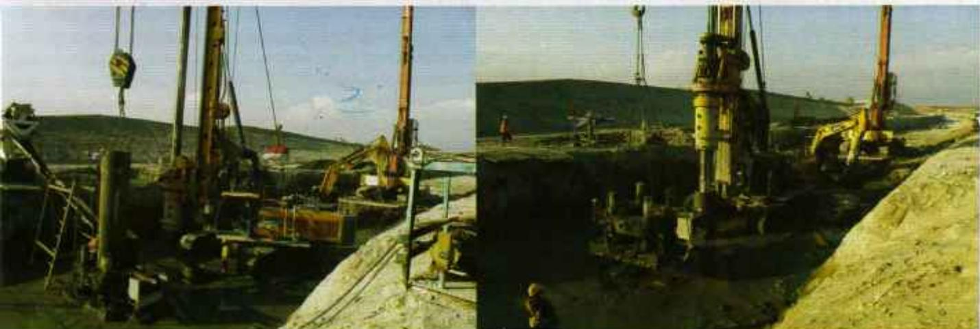
lubang dengan menggunakan metode pipa *tremie*. Posisi pipa *tremie* berada di tengah-tengah lubang dan diturunkan sampai bagian bawah lubang sebelum proses pengecoran.
