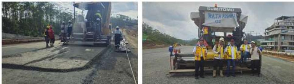
3. Penggunaan *Straight Line* dan *Straight Edge* serta *Millimeter Global Positioning System (MMGPS)* untuk memastikan kerataan permukaan dan memastikan pencapaian target *IRI*.
