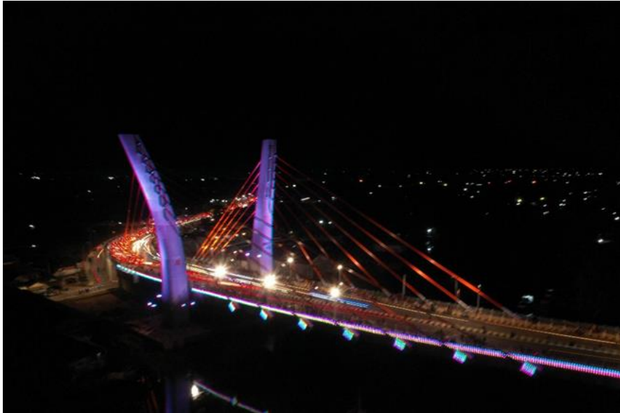
Gambar 4.10 Jembatan Sei Alalak, Kalimantan Selatan
