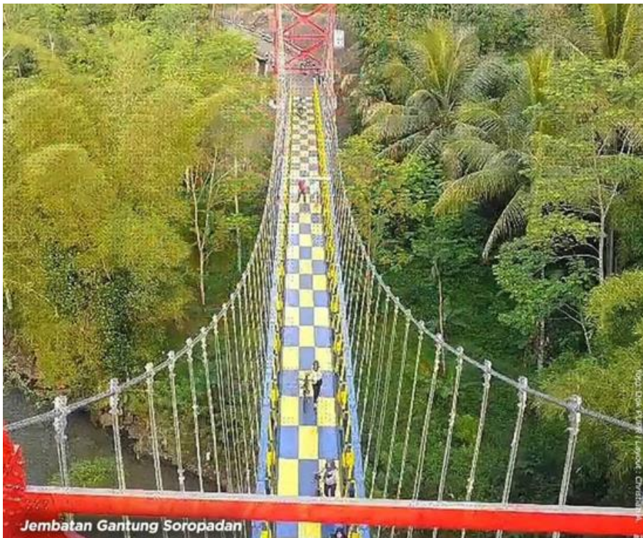
Gambar 4.7 Pembangunan Jembatan Gantung Soropadan
