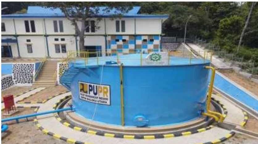
Gambar 4.11 Pembangunan IPA SPAM IKK Sulabesi Tengah
