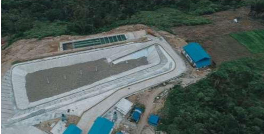
Gambar 4.13 Pembangunan TPA Dairi
